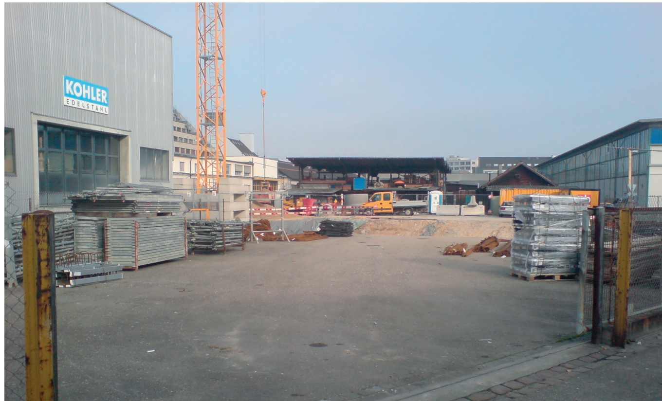
noch ist das areal eine eingezäunte öde baustelle...
